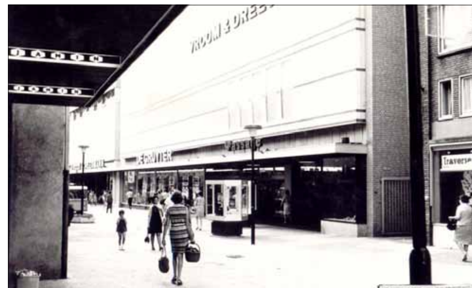
Hetzelfde aanzicht was in 1970 totaal veranderd door de nieuwbouw van V&D, de Passage en De Gruyter. De Veestraat werd autourij en voorzien van kijkvitines. (Privécollectie: Marian Bombeeck)
